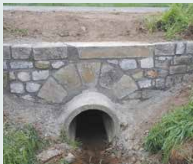
Restauration du petit pont Rue Gommeray à Fraiture
