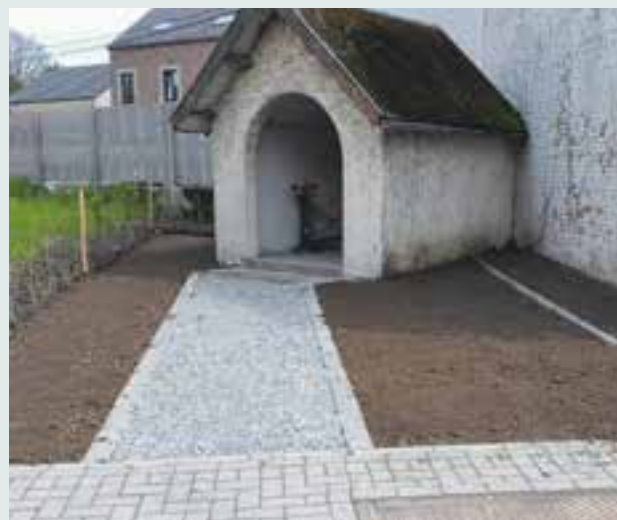
Embellissement des abords de la petite chapelle à Soheit-Tinlot
