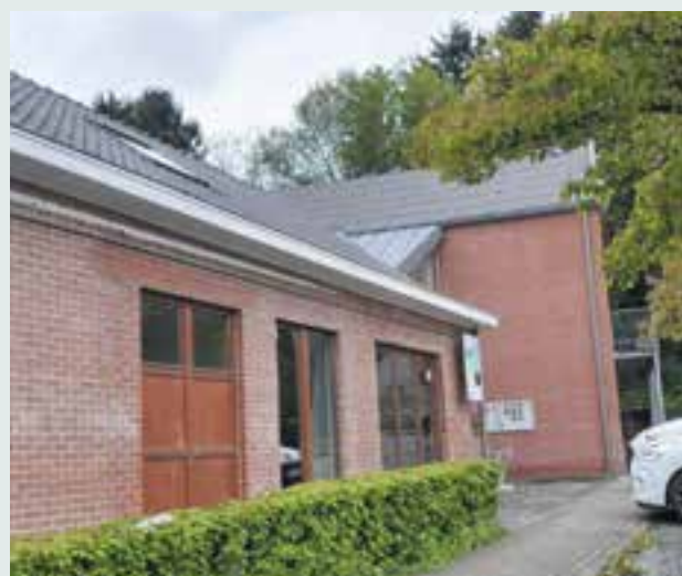
Remise en état des corniches de l'école communale
